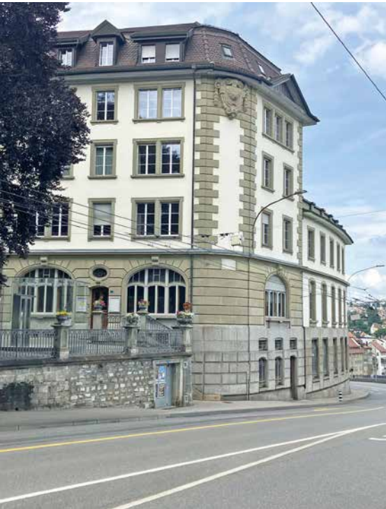
Le bâtiment de 1905, actuel Centre Sainte-Ursule.
