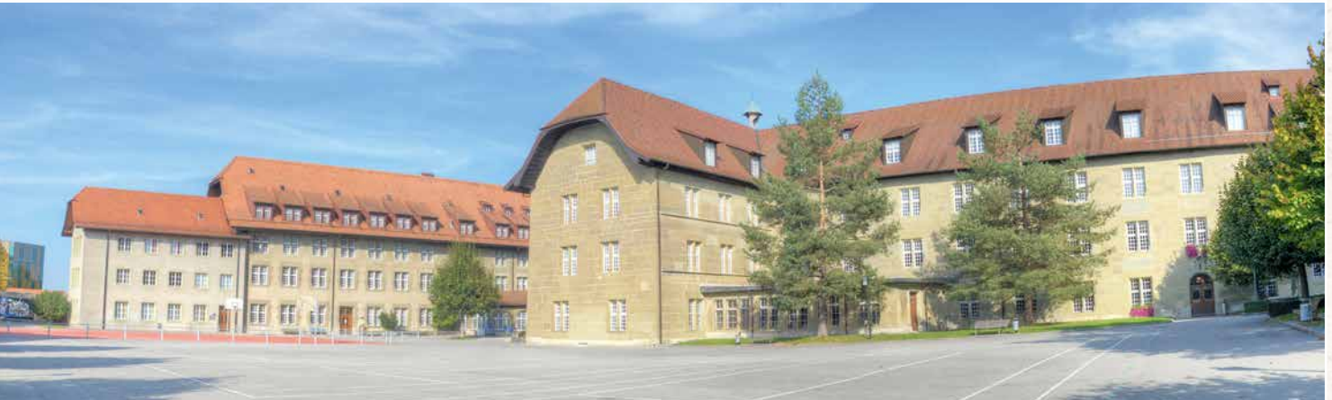
Les anciens bâtiments du collège.
