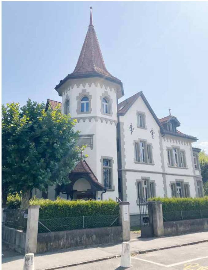
L'ancienne Maison générale, à la rue du Botzet 9.
